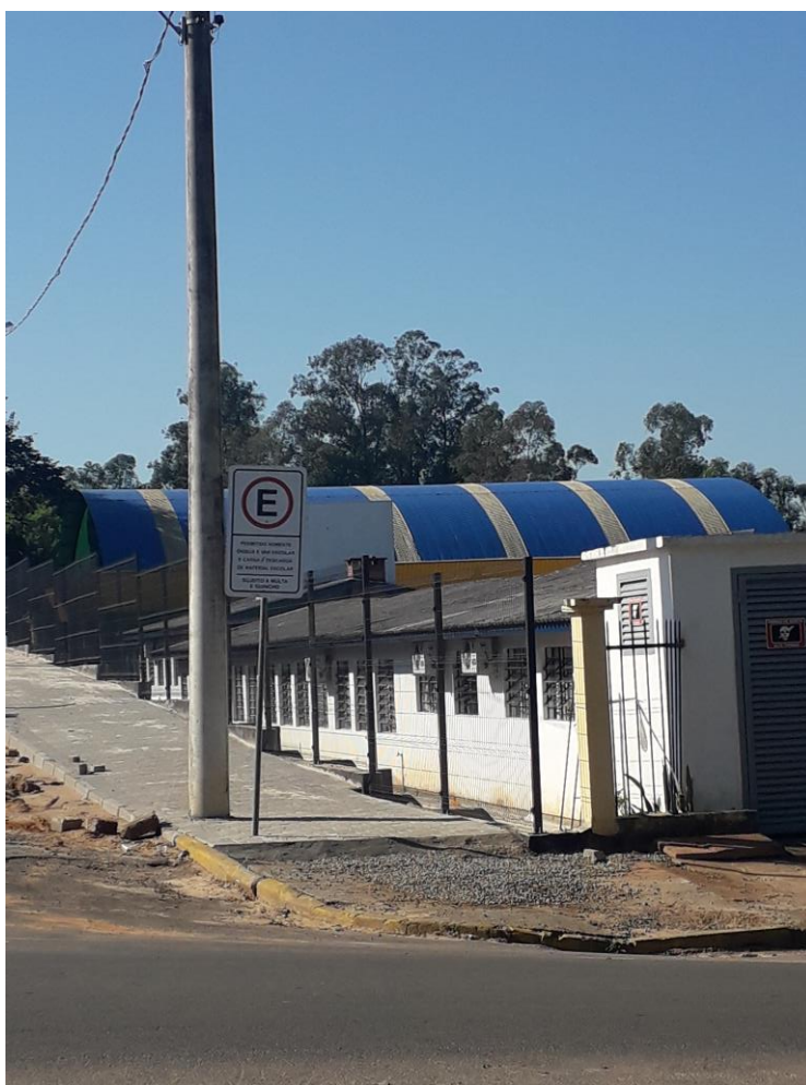
Foto do cercamento tipo Nylofor 3D instalado na escola Carlos O. Franke. Fonte: Eng. Guilherme A. Kehl.
