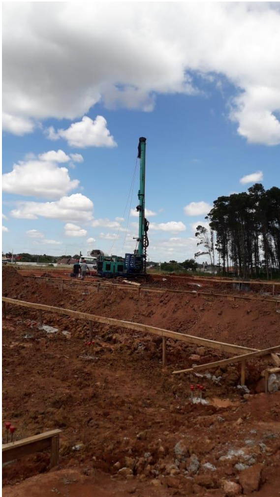
Fotos do Residencial Anita Garibaldi onde foram executadas fundações profundas tipo hélice contínua. Fonte: Eng. Liane Habeck
