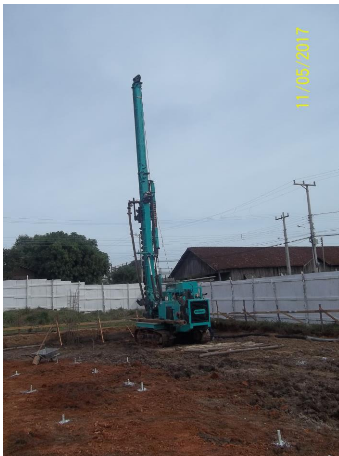
Execução de estacas hélice contínua na construção da UBS Campo Grande, em Estância Velha. Fonte: Eng. Guilherme A. Kehl
