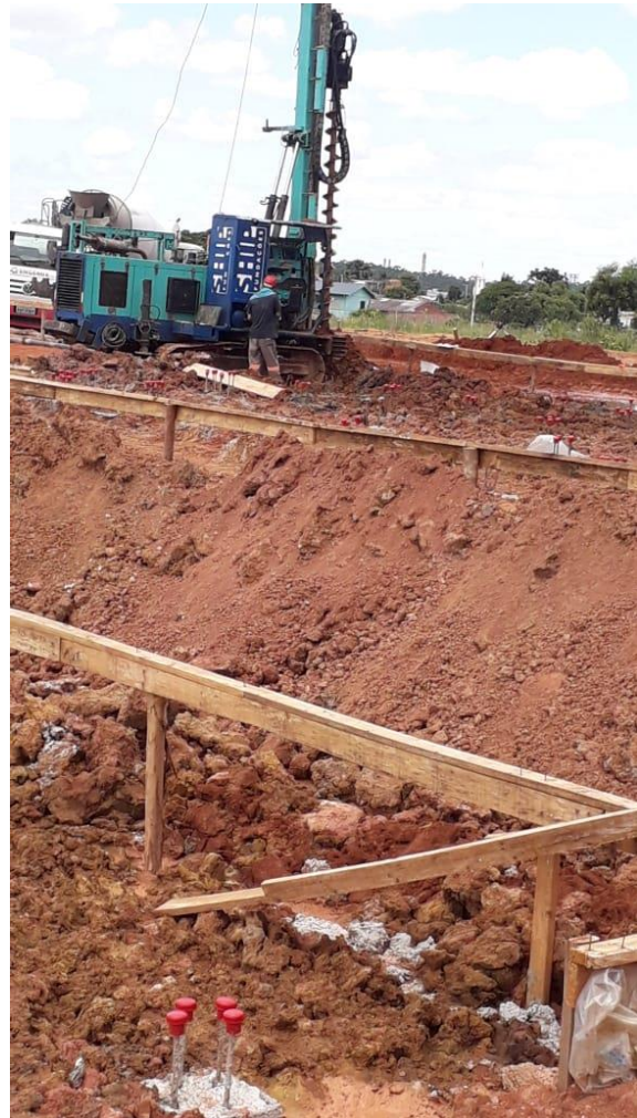
Fotos do Residencial Anita Garibaldi onde foram executadas fundações profundas tipo hélice contínua. Fonte: Eng. Liane Habeck
